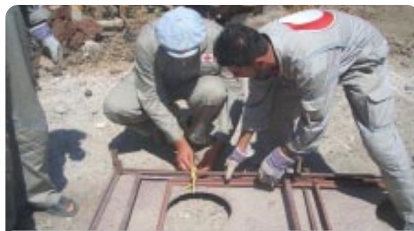
Voluntarios construyen una letrina en el curso de formación de equipos nacionales de intervención en Siria
